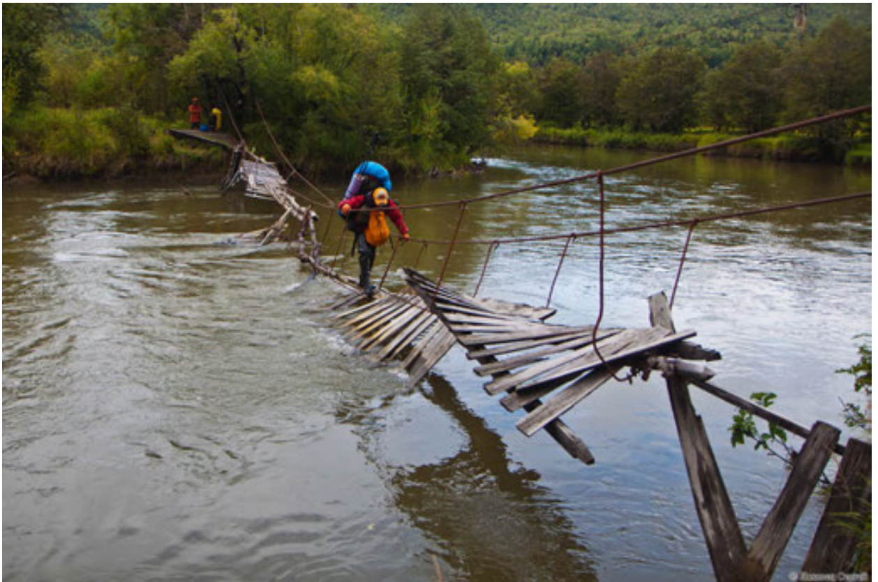
ФОТО 15. Подвесной мост через речку Левая Щапина в плохом состоянии.
