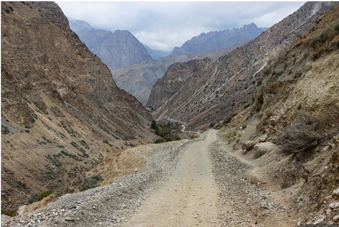
ФОТО 63. Дорога над рекой Сармад.
